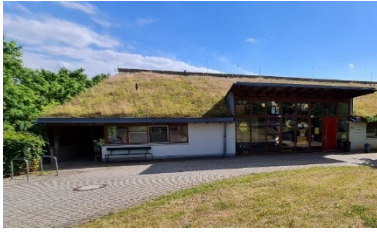
Abbildung 2-6: Kindertagesstätte mit Dachbegrünung und Solaranlage auf der Rückseite
